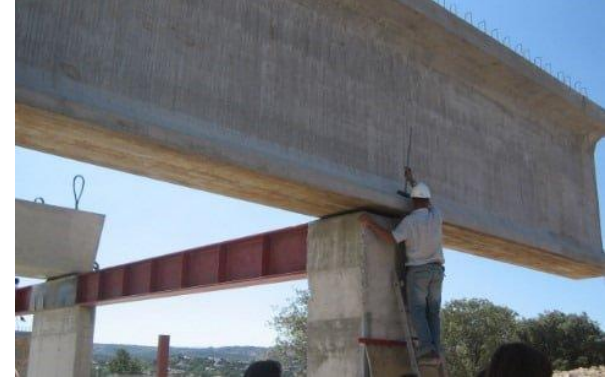
Köprü kirişlerinin yerleştirilmesi (Basit Mesnet)
